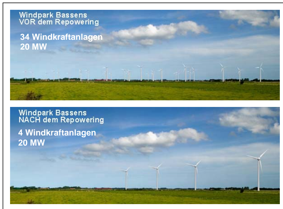
Bild 16: Windpark Bassens in Niedersachsen vor und nach Repowering (Quelle: [27])
